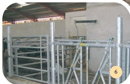
Box pour les IA ou soins en sortie de salle de traite avec porte de tri automatisée.
