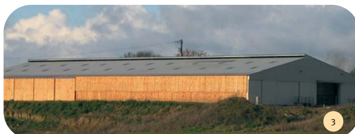
Vue du bâtiment depuis les coteaux d'en face.
