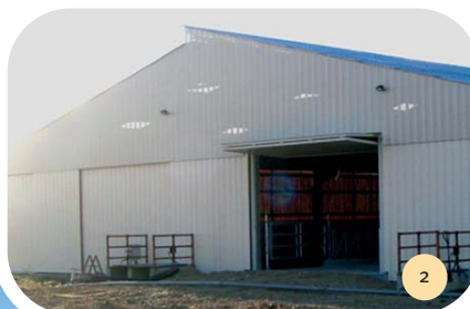
Façade Est avec accès aux fosses et brasseurs. À noter le portail "à l'espagnole".
