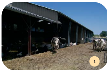
Le caillebotis extérieur d'une largeur de 5 m devant le couchage paillé.
