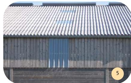
Faîtière ouverte avec tôles pare-vent interrompue avec bardage bois.
