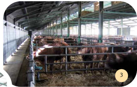
Couloir de service et de contention pour les veaux.
