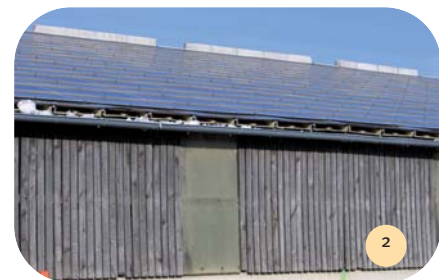
Éléments paysagers du bâtiment.
