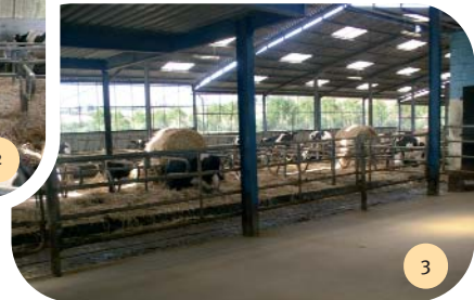
Vue de l'aire d'attente et du décrochement de toiture.
