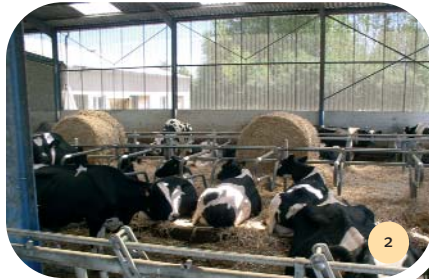
Vue du bardage perforé.
