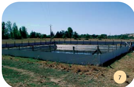
Fosse géomembrane alimentant le dispositif d'aspersion basse pression.
