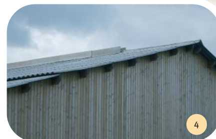
Écailles et faîtière ouverte en toiture.
