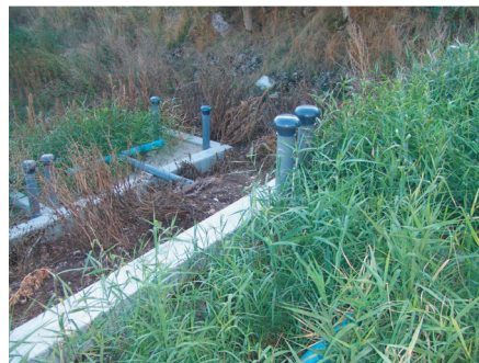
Filtere planté de roseaux - 5 mois après mise en service
