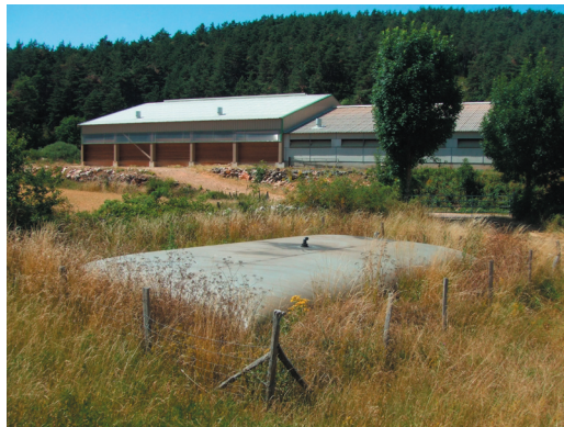
Stockage des eaux blanches
